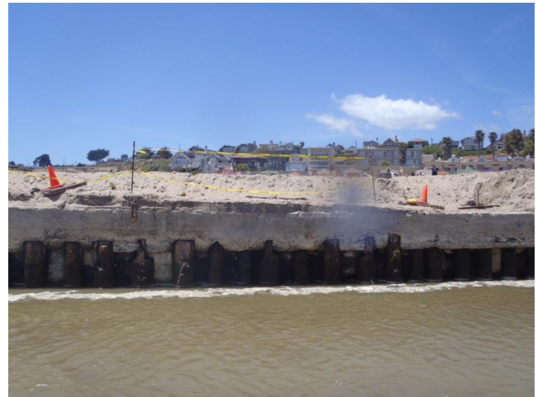
24) Sta 75 East Side
