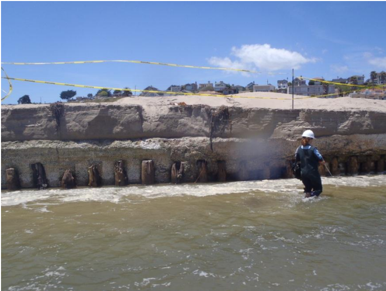
21) Sta 150 East Side
