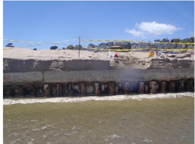
22) Sta 125 East Side
