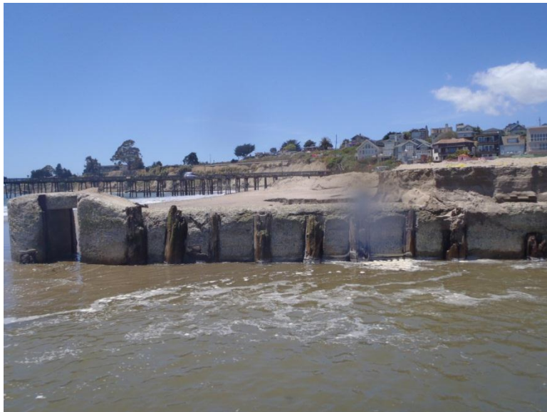
19) Sta 200 East Side
