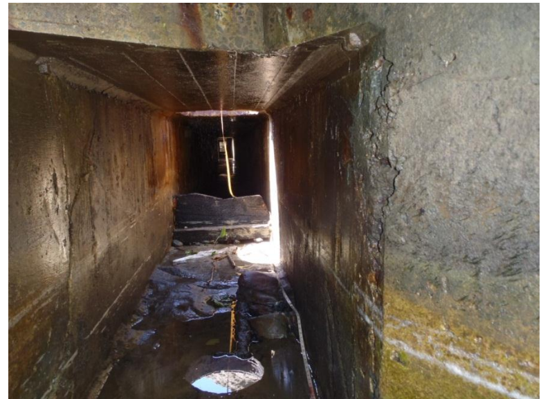
4) Sta 10 at Angle
