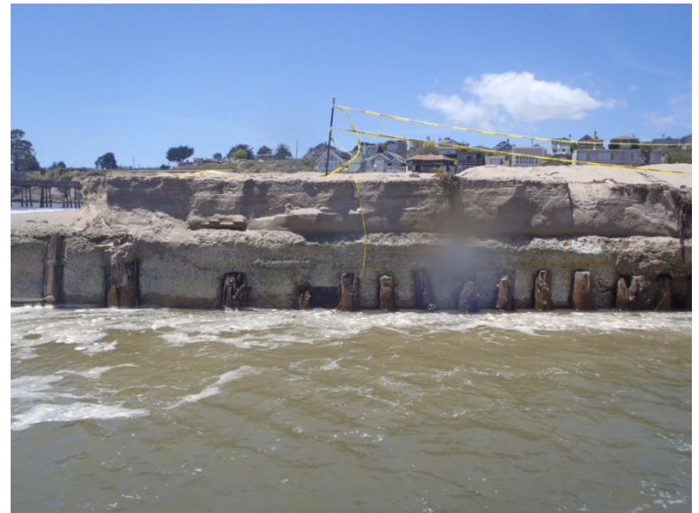
20) Sta 175 East Side
