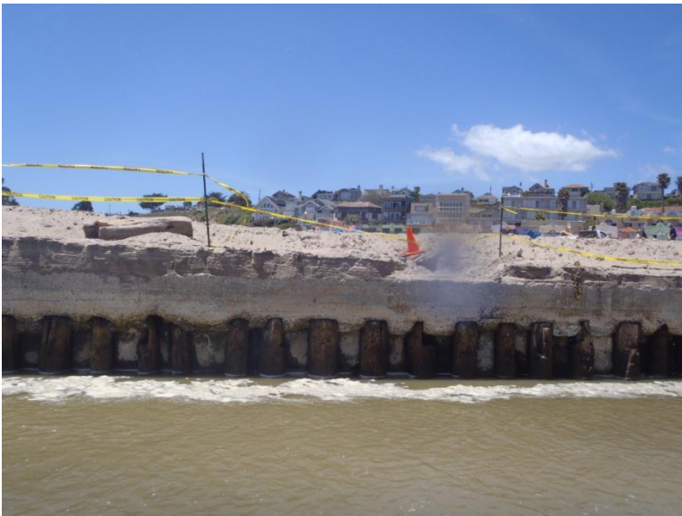
23) Sta 100 East Side
