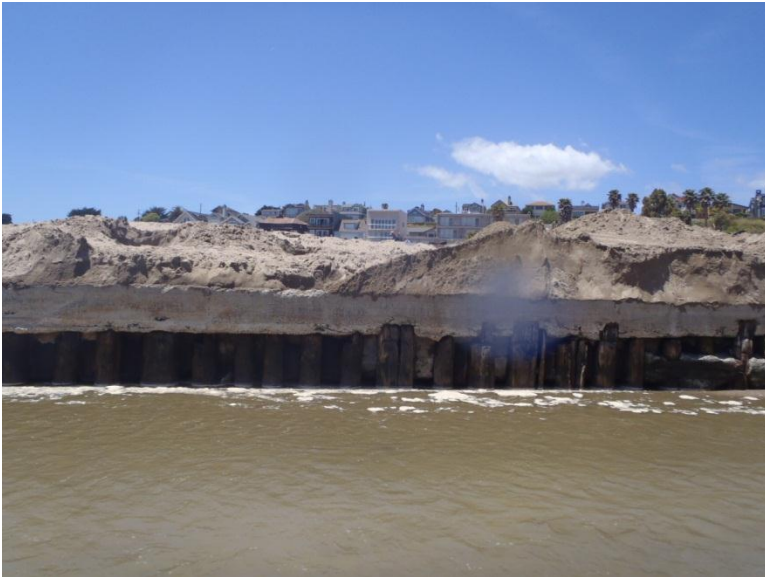
25) Sta 50 East Side
