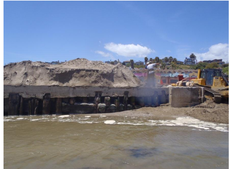
26) Sta 0 East Side
