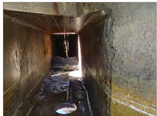
STA 0+10 AT ANGLE
