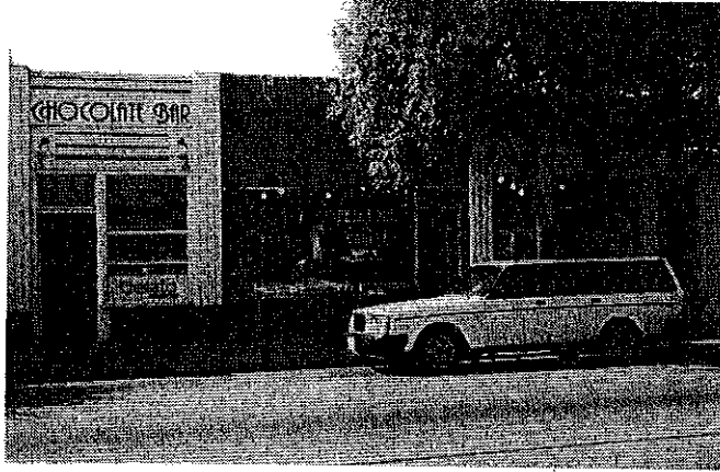
207 Capitola Avenue Moderne c. 1930
